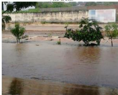
Figura 18 – Alagamento ocorrido ao longo do trecho canalizado do Córrego Josefa Gomes, Vila Bela.
